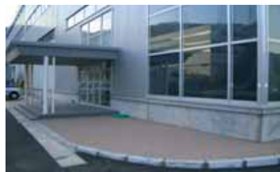
レンガを再生し、弊社工場玄関部に施工
